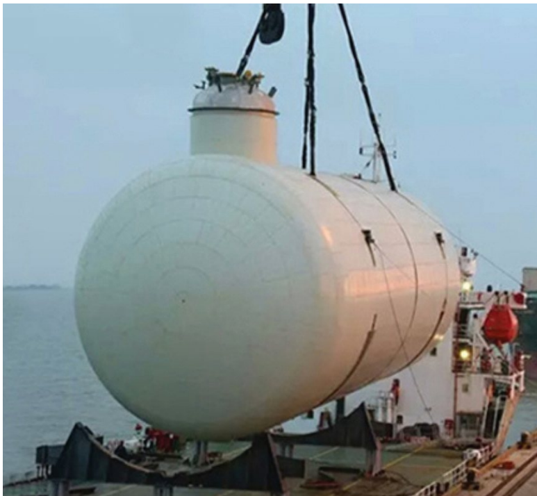
LNG Tank Insulation for Bunkering Vessel
